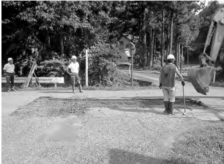
写真4 I区アスファルト除去作業
