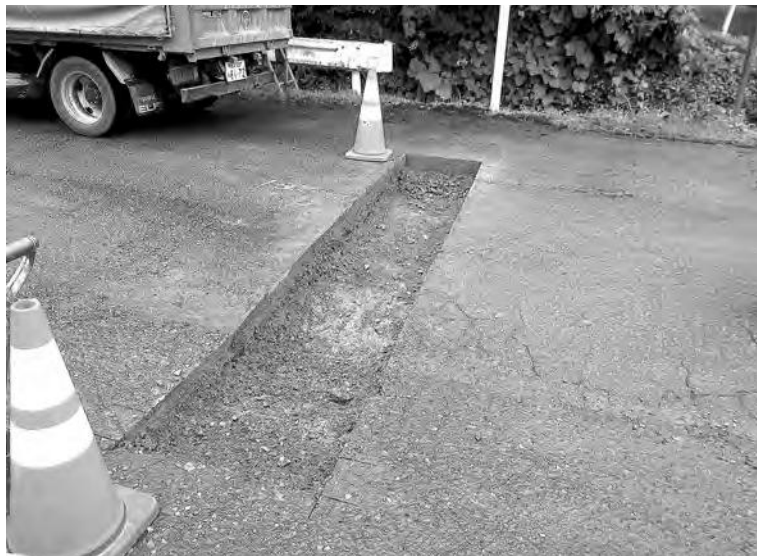
写真1 T2 アスファルト除去
