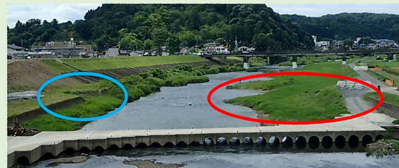
【磐井橋から上流方向(現状)】
