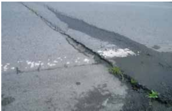
路面の亀裂
