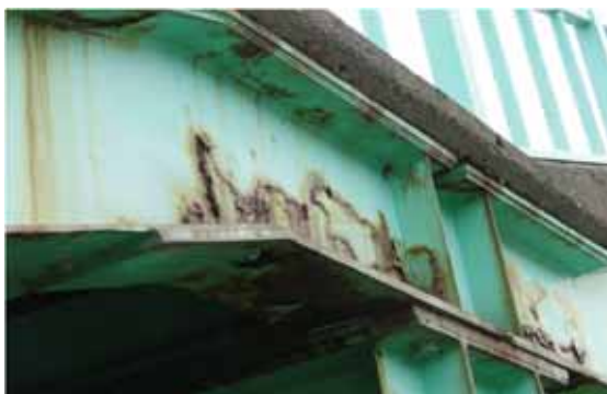
主桁の腐食
