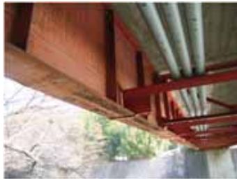
広範囲の腐食
