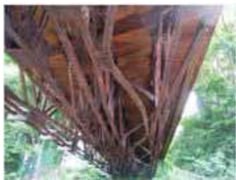
著しい腐食による板厚減少(広範囲)
