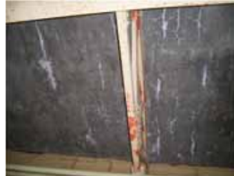
床版のひびわれ・遊離石灰の析出
