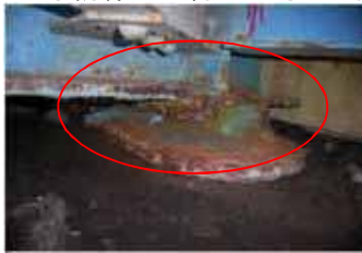
桁端部の腐食
