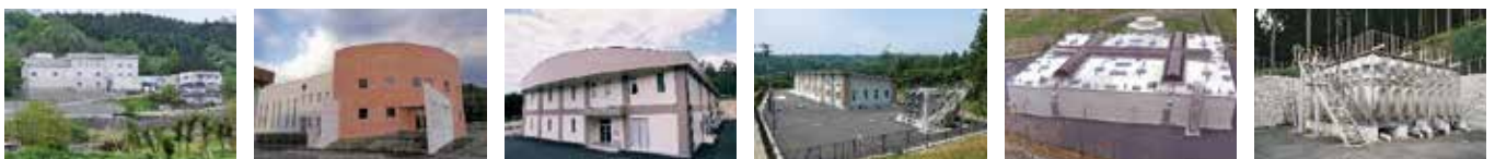
一関市の水道施設（左から脇田郷浄水場、大森浄水場、上巻浄水場、渋民浄水場、三本松浄水場、烏兎ヶ森配水池）
