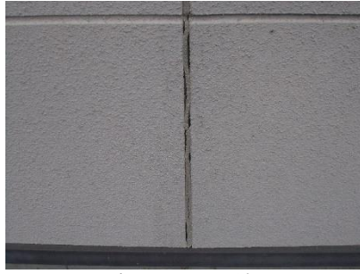
外壁 目地のひび割れ
