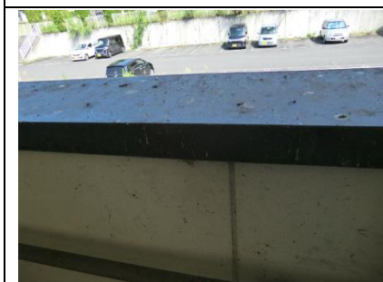
廊下 壁 鳥のフン
