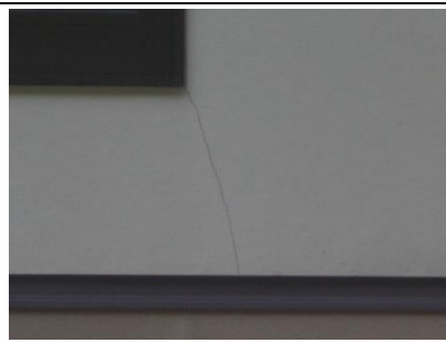
外壁 ひび割れ
