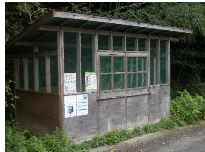
ゴミ置場 劣化
