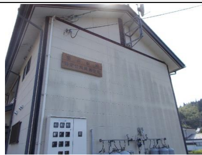
西面外壁 汚れ
