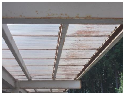
屋根 鉄骨サビ
