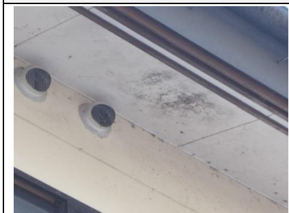
北面外壁 軒裏 汚れ
