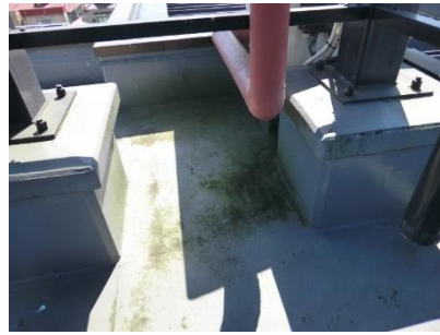
屋上 滞水跡あり、変色あり
