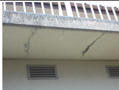
南面外壁 ひび割れ、汚れ
