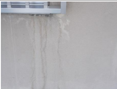
外壁 ひび割れ、汚れ
