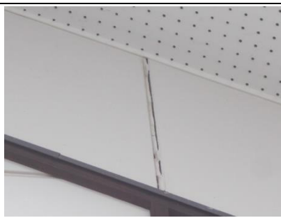
外壁 目地のひび割れ
