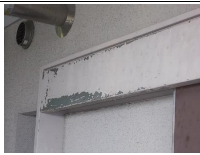
廊下 玄関 塗装剥離
