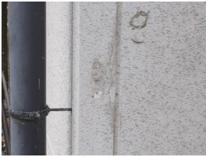
外壁 ひび割れ
