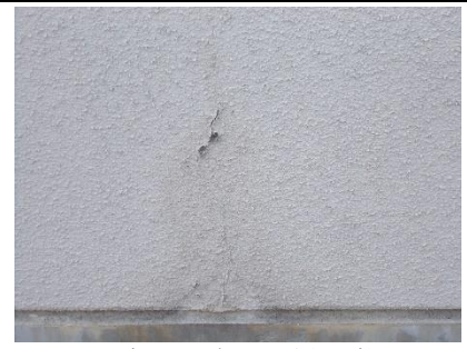
外壁 ひび割れ、塗装剥離
