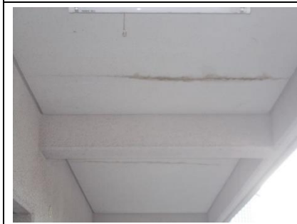
廊下 天井 ひび割れ多数あり
