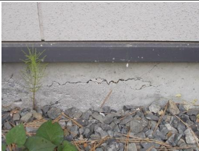
基礎 ひび割れ
