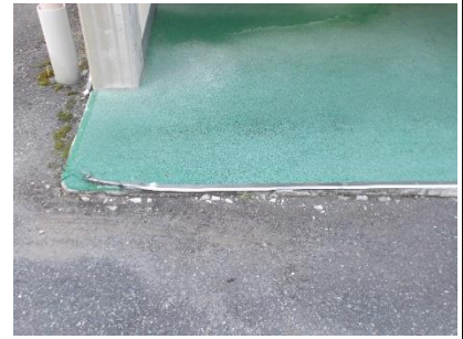
階段室 入口 破損
