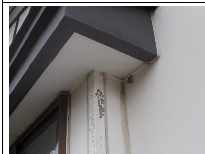
外壁 塗装剥離
