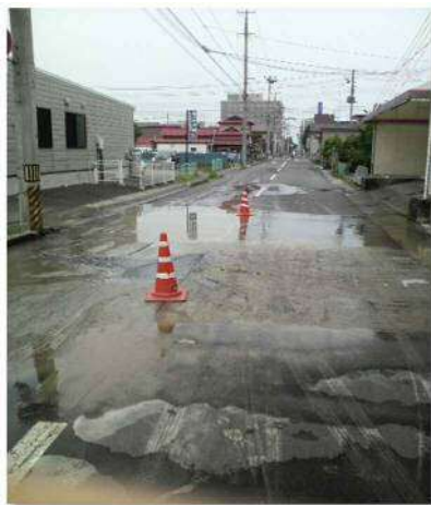
老朽管からの漏水の様子(八幡町地内(左)、萩荘字高梨南方地内(右))
