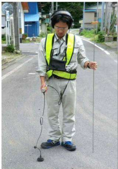
探知機による漏水調査の様子
