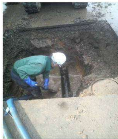
老朽管からの漏水の様子(八幡町地内(左)、萩荘字高梨南方地内(右))
