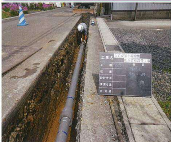
配水管(耐震管)布設替工事の様子
