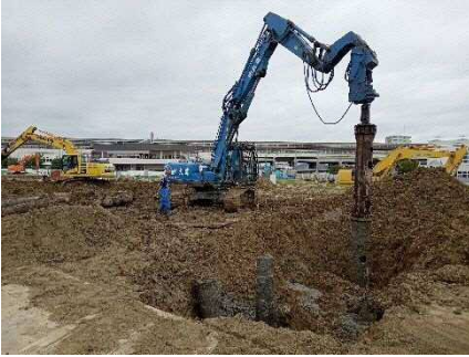
【基礎杭引き抜き】
