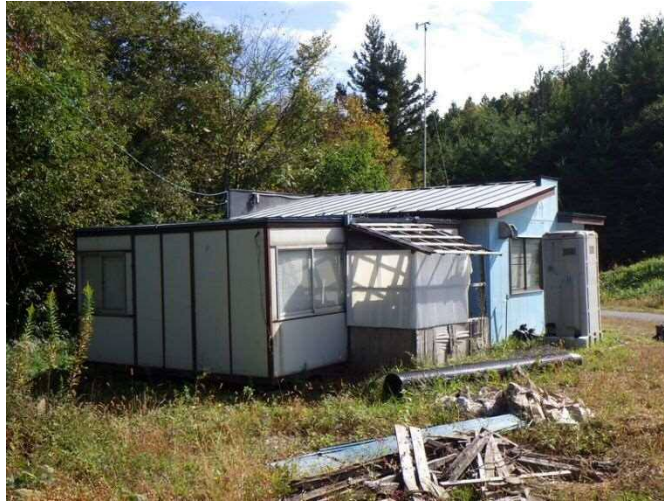
写真 6. 8-20 現地状況（構造物）
