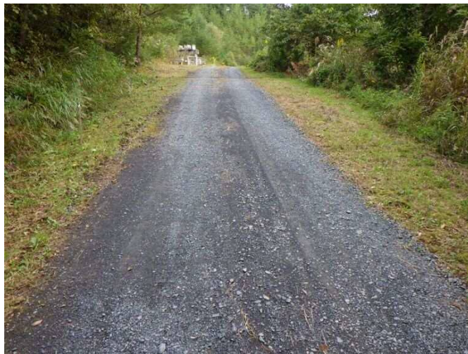
写真 6. 8-21 現地状況（道路）
