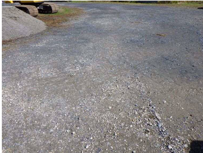
写真 6.8-19 現地状況（造成地）
