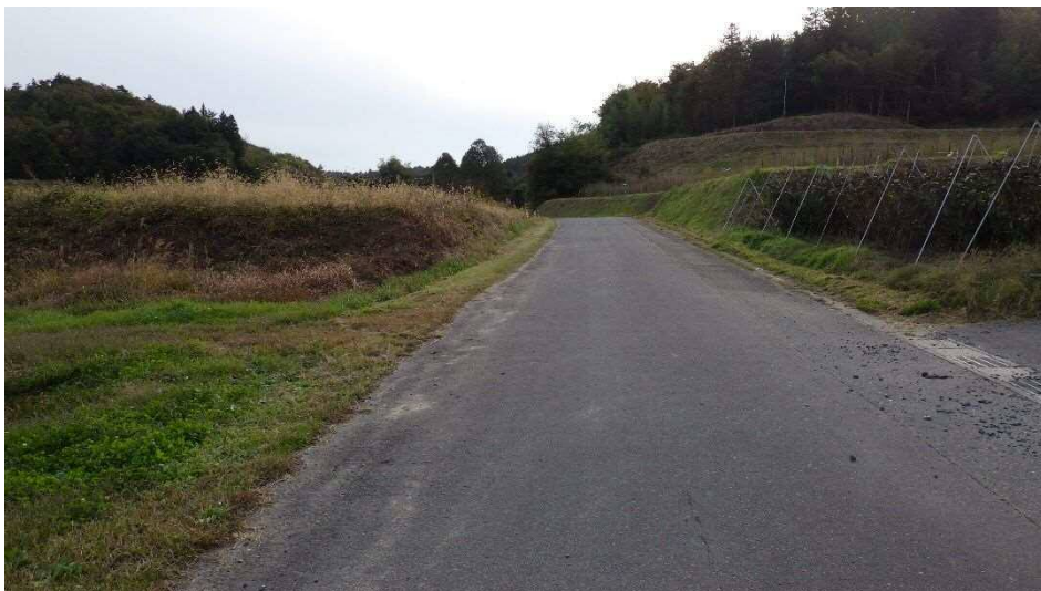
写真 6. 2-3 No. 3 地点の地表面の状況
