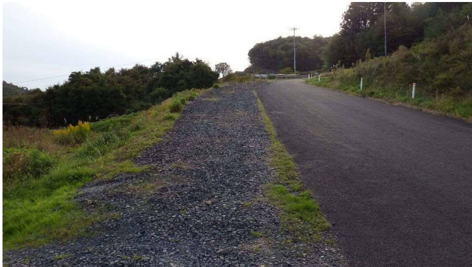
写真 6. 2-2 No. 2 地点の地表面の状況
