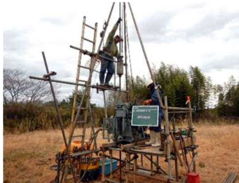
写真 ボーリング作業状況
