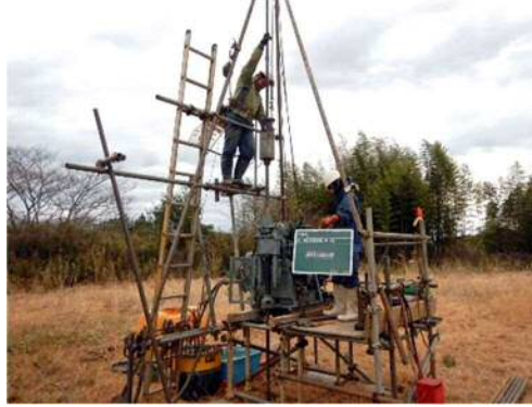
写真 ボーリング作業状況
