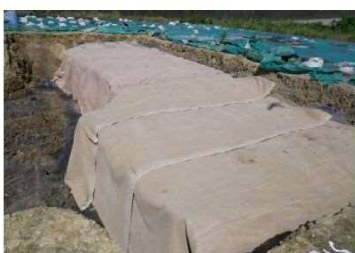
【写真2 ベントナイトシート敷設】
