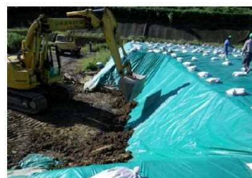
【写真3 クロスラムシート敷設】
