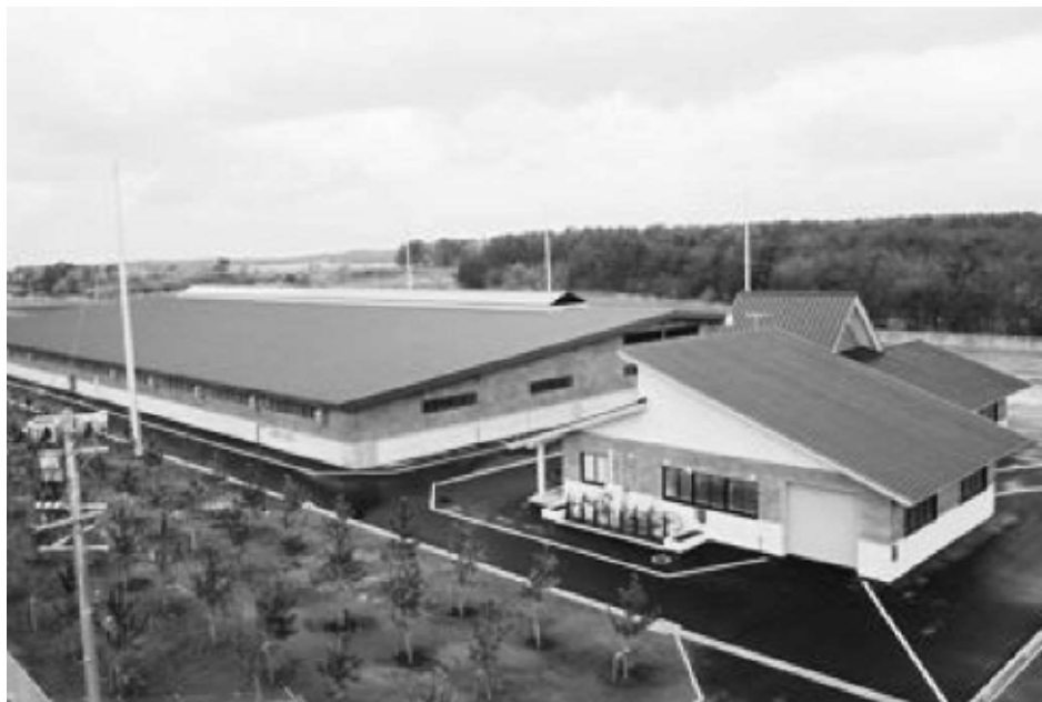
図 4 クローズド型最終処分場外観
