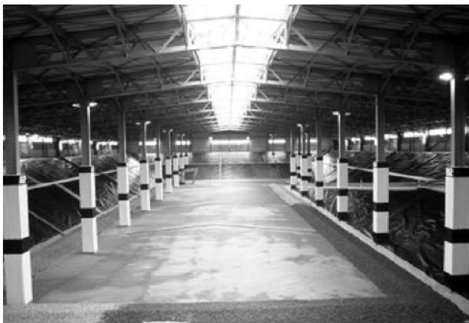
図 6 クローズド型最終処分場内部
