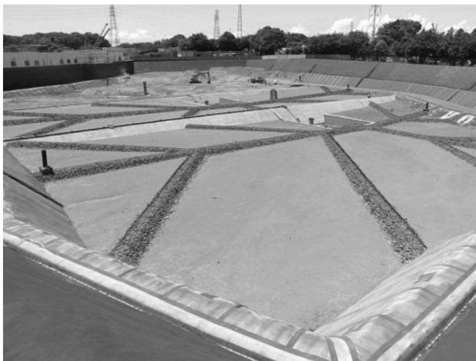
図 3 オープン型最終処分場埋立地作業状況
