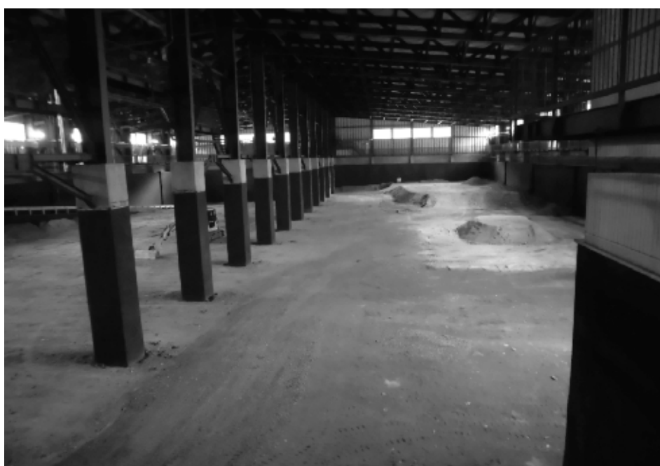
図 7 クローズド型最終処分場埋立地作業状況
