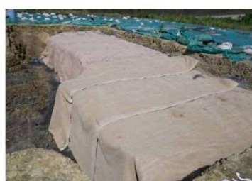
【写真2 ベントナイトシート敷設】
