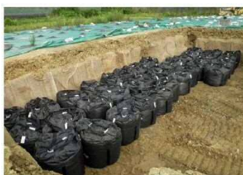
【写真1 飛灰の入ったフレコン】
