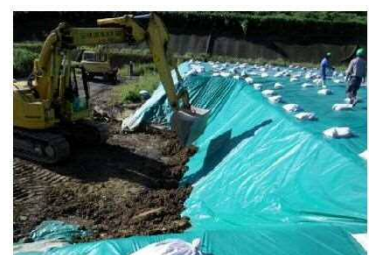
【写真3 クロスラムシート敷設】
