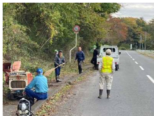
道路愛護作業追加作業支障木の刈り払い
