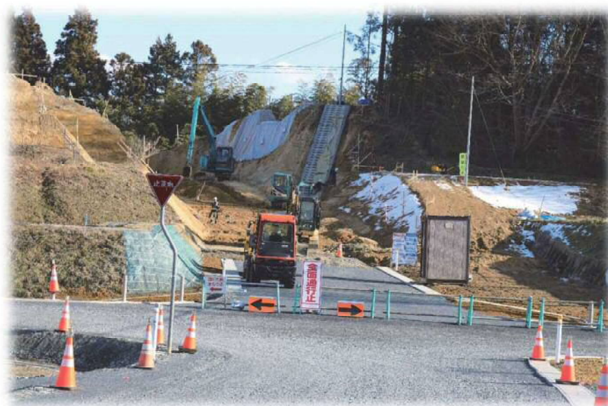
整備が進む 道路改良工事 (市道丸木舞川線)
