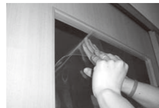
ガラス飛散防止フィルムの設置
