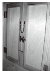
金具で扉を固定
