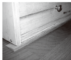
転倒防止板の設置
