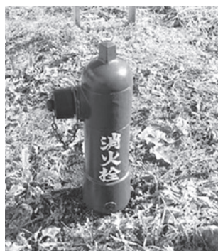
↑ 地上式消火栓
