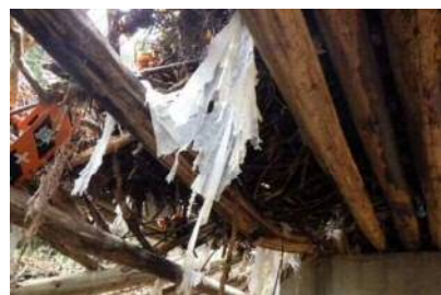
木桁の腐朽
