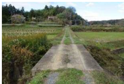
川ノ口 2 号橋(供用 53 年)
