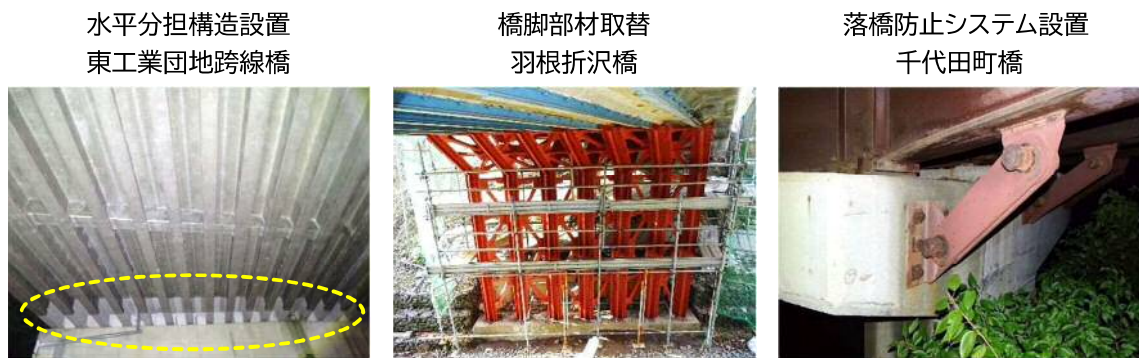
写真-3.8 耐震補強対策事例
