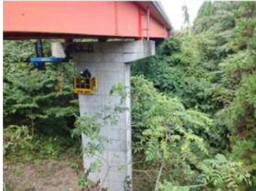
ゴンドラ車による点検
