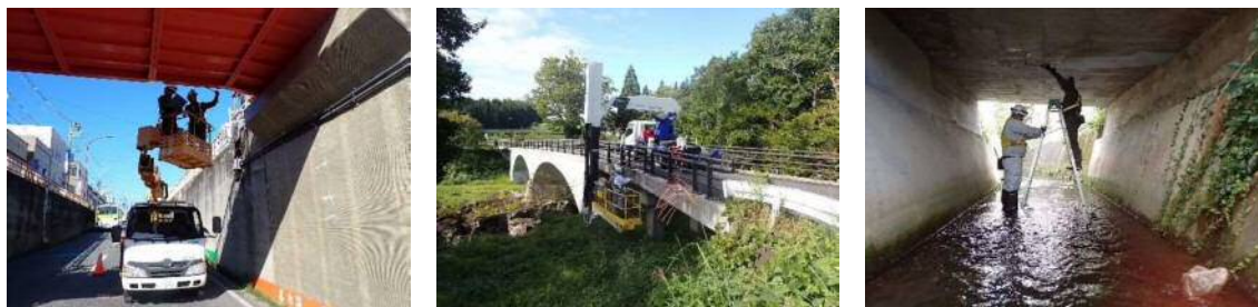
写真-3.1 定期点検状況
