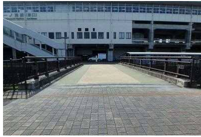
なのはな橋(供用 20 年)
