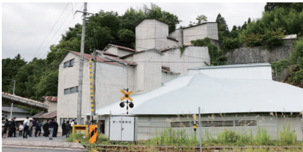
工場東棟は屋根もきれいに張り替えられました
