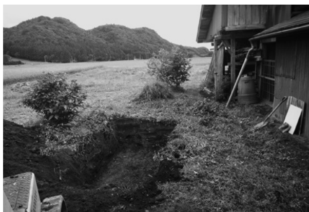
写真17 トレンチ掘削状況
