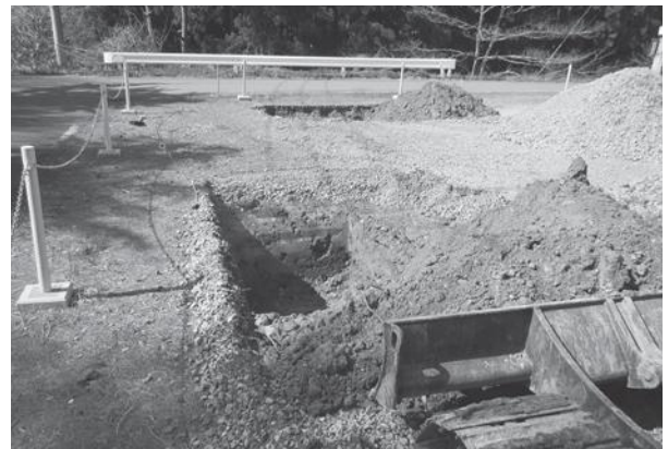
写真8 トレンチ掘削状況
