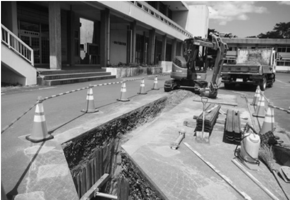
写真45 立会2地点作業風景
