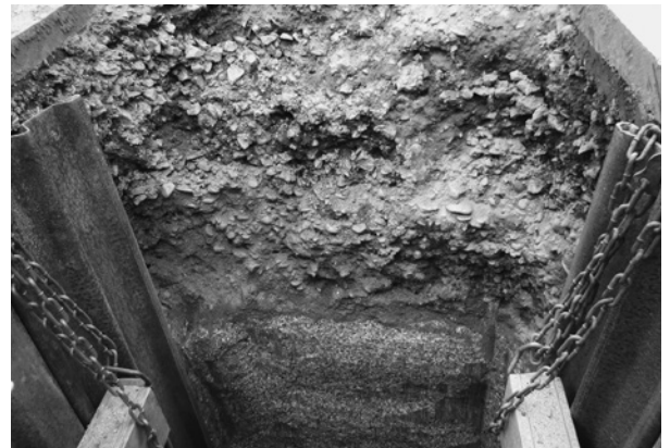
写真48 立会1地点土層堆積状況
