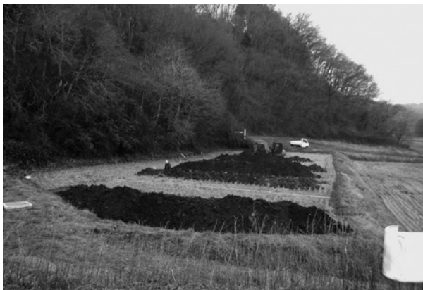
写真24 トレンチ掘削状況
