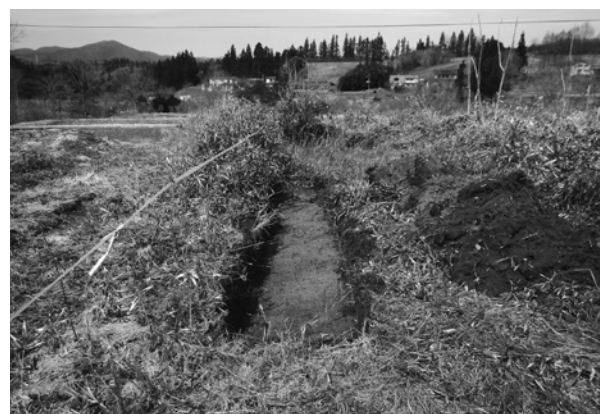
写真33 トレンチ掘削状況
