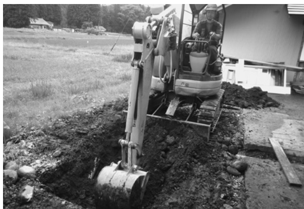
写真53 工事対象地掘削状況
