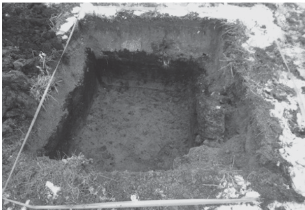
写真27 トレンチ掘削状況
