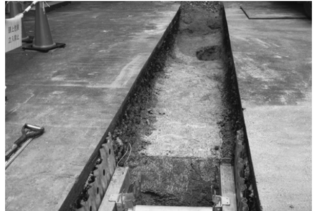
写真46 立会3地点地山面検出状況
