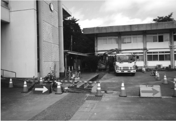
写真43 立会3地点遠景
