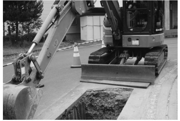
写真44 立会1地点作業風景
