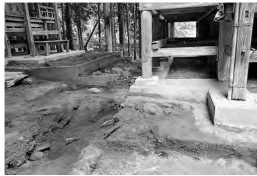
SX06検出状況
