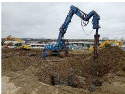
【基礎杭引き抜き】
