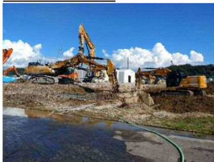
【土間基礎解体】
