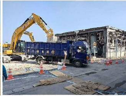
【廃材搬出状況】
