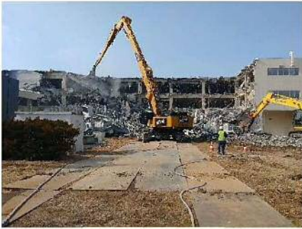
【上屋解体状況】
