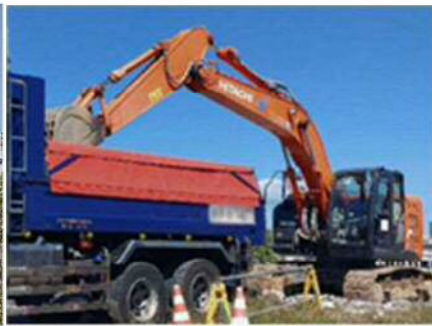
【土壌汚染対策（掘削除去）】
