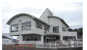
旧川崎農業活性化センター
