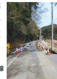
市道二日町曲田線の改良舗装工事
