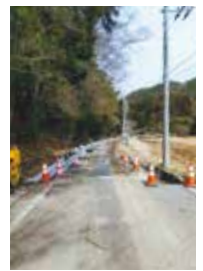
市道二日町曲田線の改良舗装工事
