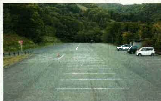
作業後の駐車場
