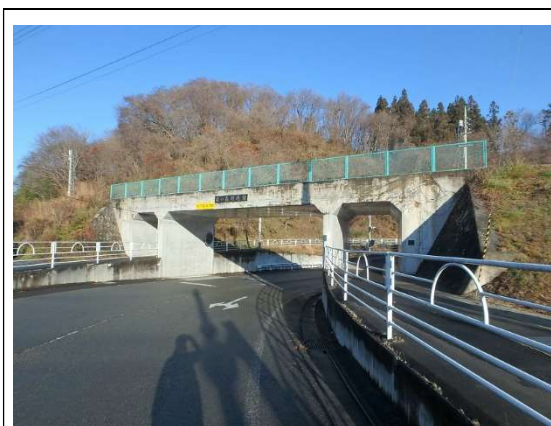
萩の森跨道橋
