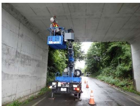
従来の高所作業車による点検
