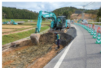
改築作業中の道路
