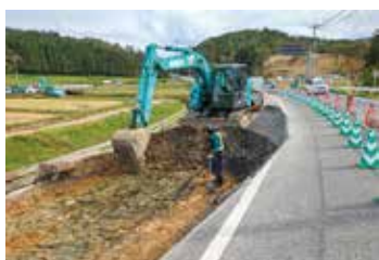
改築作業中の道路
