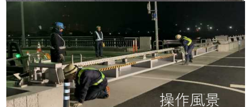
磐井橋左岸陸閘
