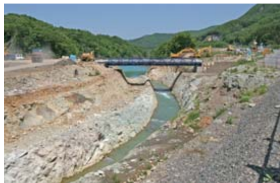
▶崩落した大量の土砂が磐井川をせき止めた市野々原地内の仮排水路。本復旧に向けて6月から仮排水路の拡幅工事が始まった。右側は国道342号(6月2日撮影)
