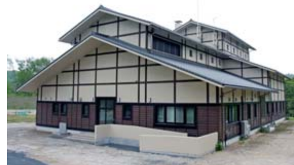
供用を開始した千厩浄化センター
