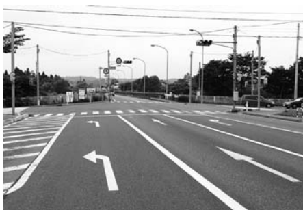
4車線化の継続実施を要望した国道4号(一関大橋付近)
