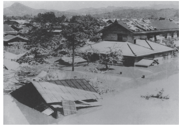
↑五十人町付近。磐井川が氾濫し濁流が流れ込んだ
