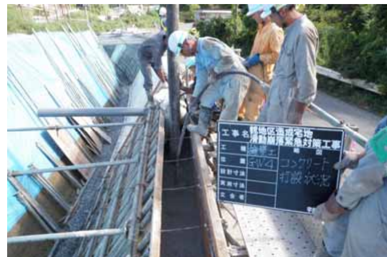
コンクリート打設状況
