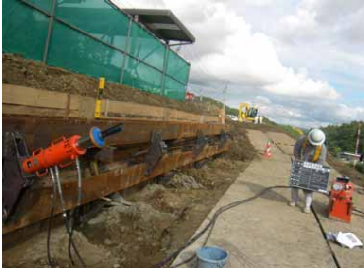
アンカー定着荷重確認
