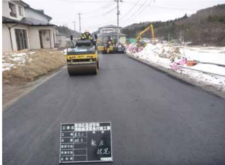
アスファルト転圧
