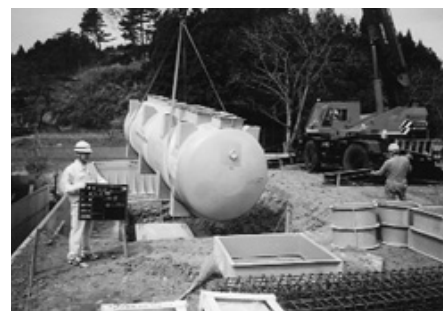
合併浄化槽
