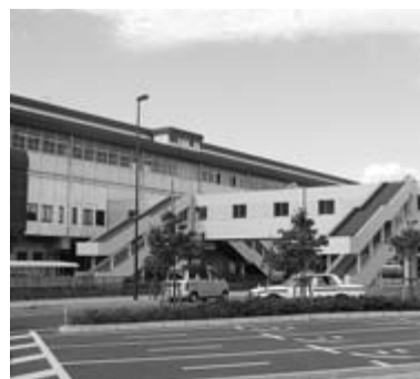
東西自由通路の早期実現が望まれる駅東口
