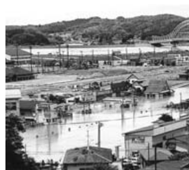
平成14年千厩川越流内水被害状況
