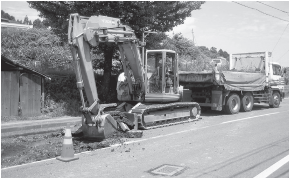
災害復旧道路工事
