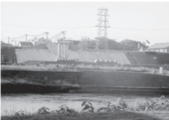
着々と進む磐井川堤防改修工事
