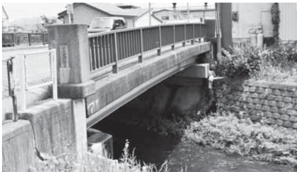
補修工事が予定されている吸川橋
