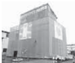
開発が進む除染プラント
