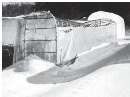
雪害によって倒壊したパイプハウス
