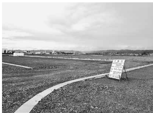
新花泉小学校建設現場
