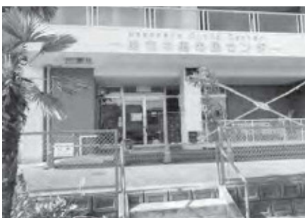
建て替えが想定される中里市民センター
