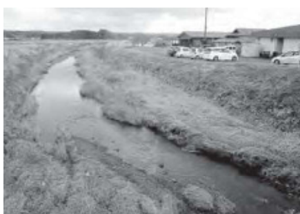
河道掘削を行い、水害の未然防止を
