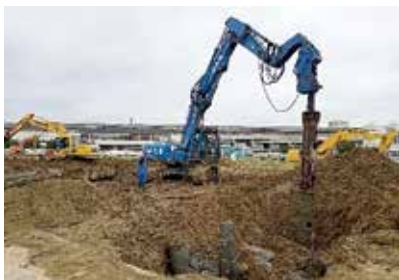
工事が進むNEC跡地
