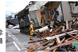
早めの耐震診断を(能登半島の倒壊状況)
